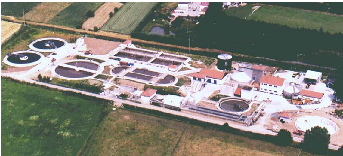
Abbildung 1: Luftbild der Kläranlage
