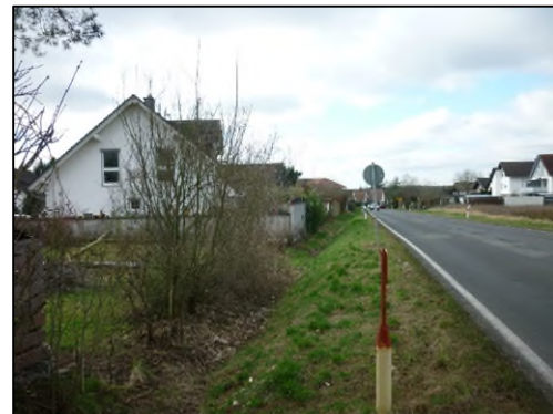
Entwässerungsgraben entlang der L 3115
