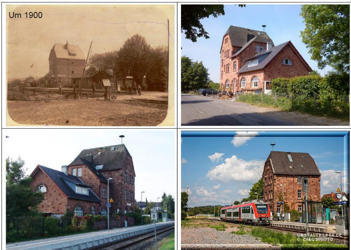
Abbildung 1: Ehemaliges Bahnhofsgebäude (außerhalb Plangeltungsbereich)
